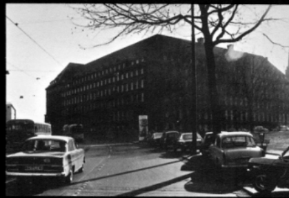
Kraftwerk Springorum FKH Städtische Sparkasse Rathaus
